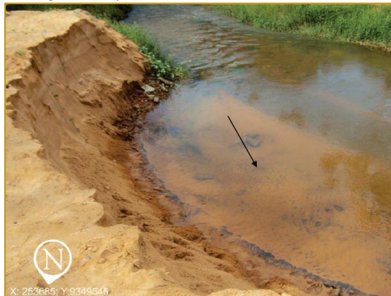
Figura 3: processo erosivo e assoreamento na margem esquerda do Rio Pitimbu (13/05/2011)
