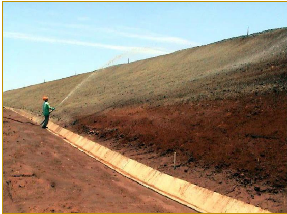
Figura 6: Hidrossemeadura sobre biomanta em talude de aterro (20/05/2011)
