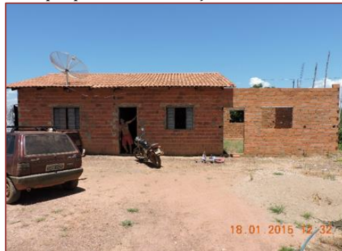
Fotografia 1 – Casa própria em construção no Assentamento Olga Benário
