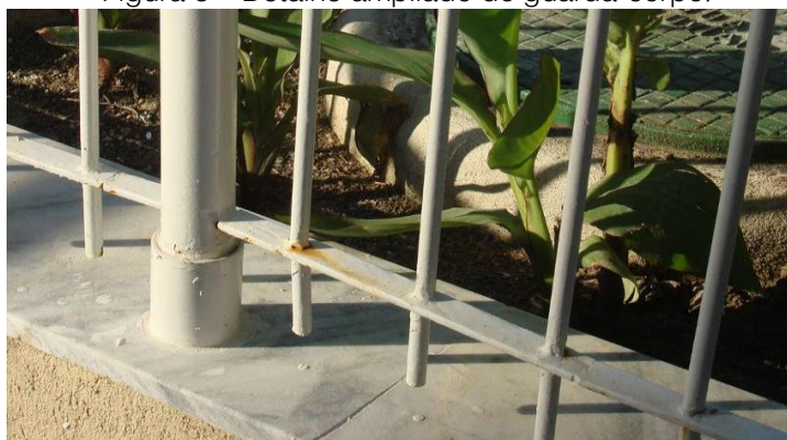
Figura 8 – Detalhe ampliado do guarda-corpo.
