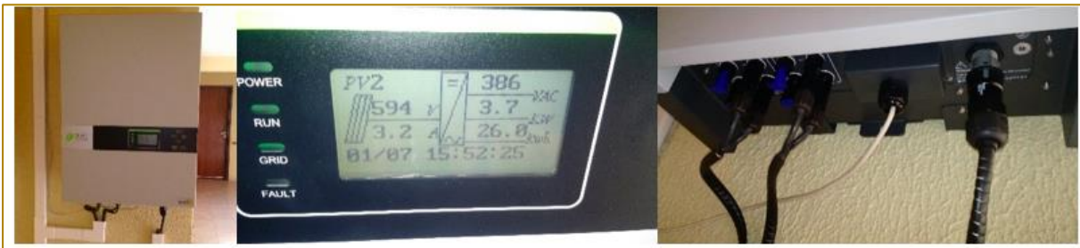
Figura 9: a) Inversor, b) IHM do Inversor, c) Entradas e Saída do Inversor
