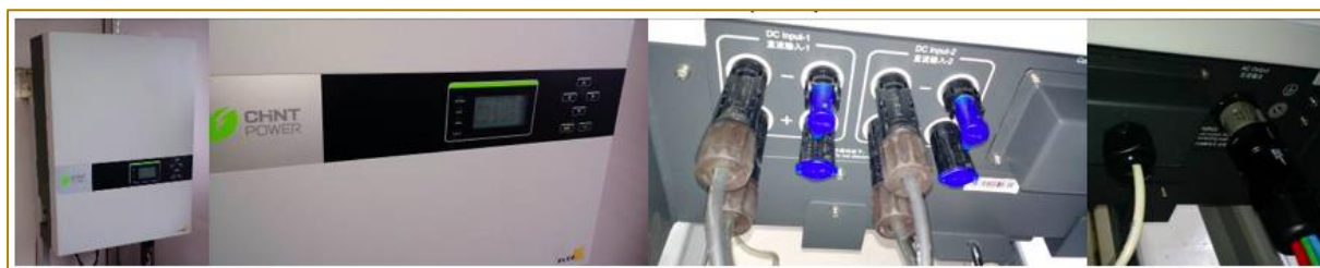
Figura 4: a) Inversor, b) IHM do Inversor, c) Entradas do Inversor e d) Saída do Inversor
