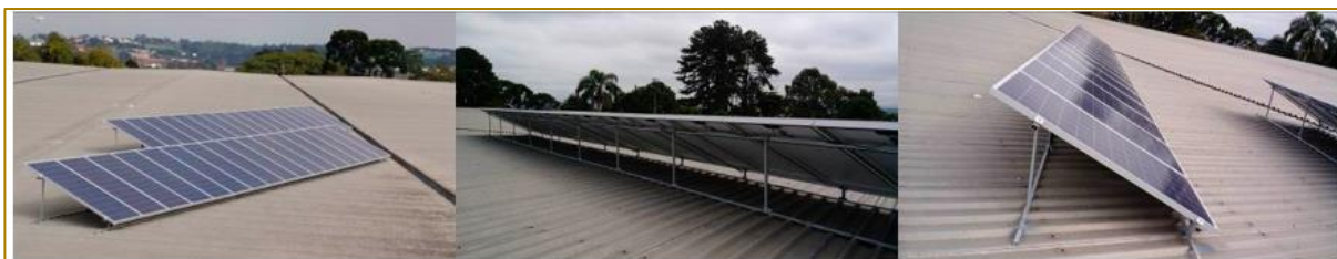
Figura 3: a) Arranjo físico dos Painéis do SFVCR, b) Estrutura de Fixação e c) Espaçamento entre os painéis
