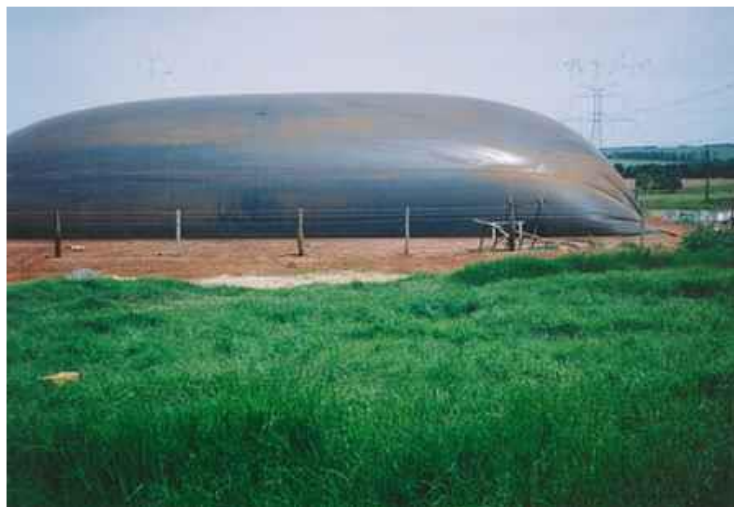
Figura 5: Biodigestor modelo canadense.
