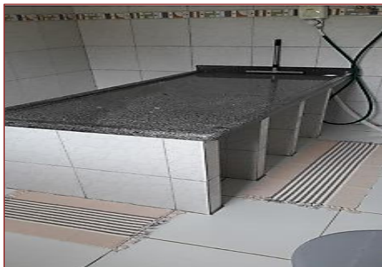
Figura 4: Bancada do banheiro adaptado
