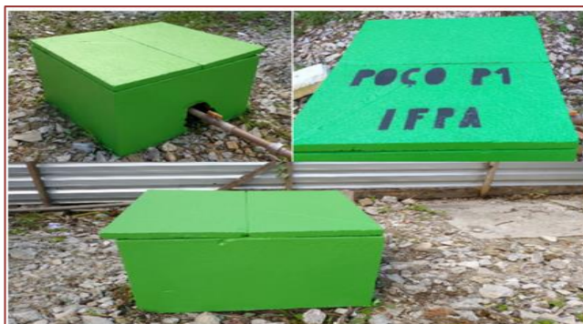
Figura 4 – Manutenção preventiva e corretiva – poço e cisterna – Campus Belém
