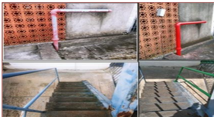
Figura 8 – Serviço de manutenção – Rede de Combate a incêndio, Campus Belém, 2021
