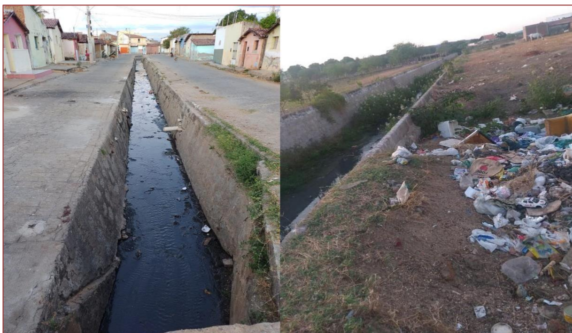
Figura 3: Canais de drenagem com lançamentos de esgotos e resíduos próximos às residências
