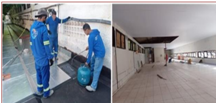
Figura 7 – Serviço de manutenção no 1º Piso, Bloco H
