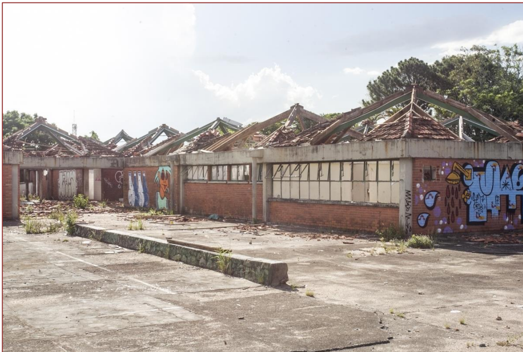
Figura 9 – Escola Dayse Werner Salles – demolição em 2018/2019
