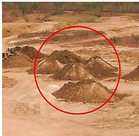
a) Solo usado para a camada de base
