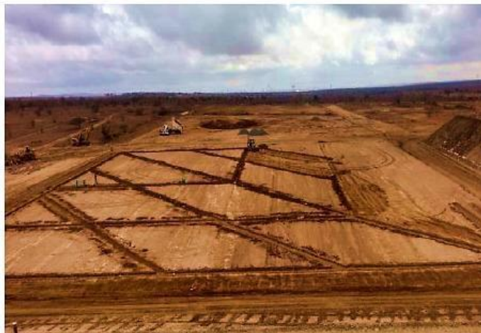
b) Execução da camada de base
