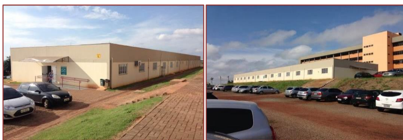
Figura 1 - Vista Externa do Bloco de Pesquisas
