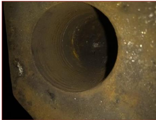
Figura 4 - Rosca M42 de um mancal vertical em condições de desgaste
