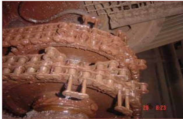
Figura 3 - Retirada de um dos elos da corrente para o funcionamento da peneira de rolos
