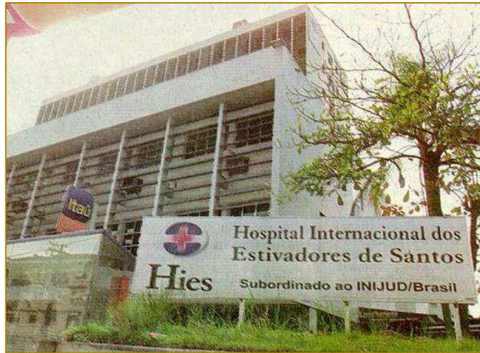
Figura 8 Frente do Hospital dos Estivadores de Santos
