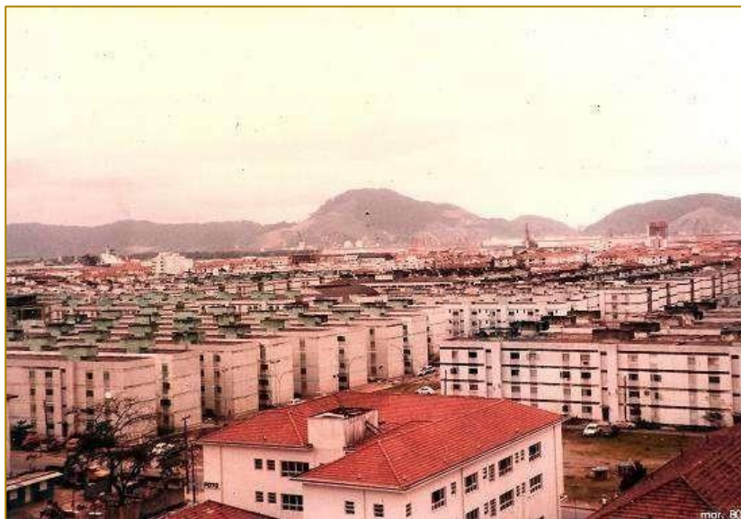
Figura 9 Foto aérea do Conjunto Habitacional
