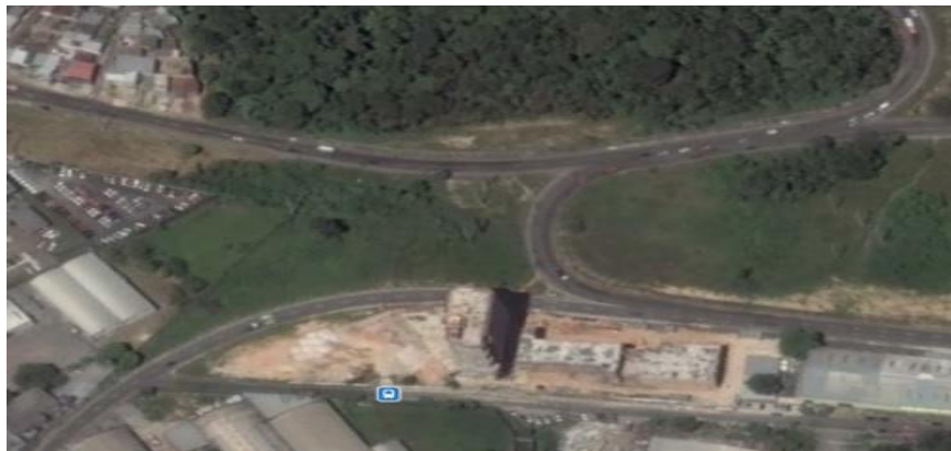
Figura 1 - Locação da obra 1
