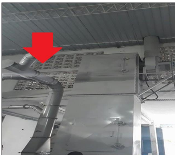
Figura 3 - Instalação de exaustores no Bamburi
