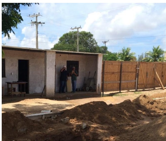
Figura 3 Reunião do mestre de obra com o engenheiro
